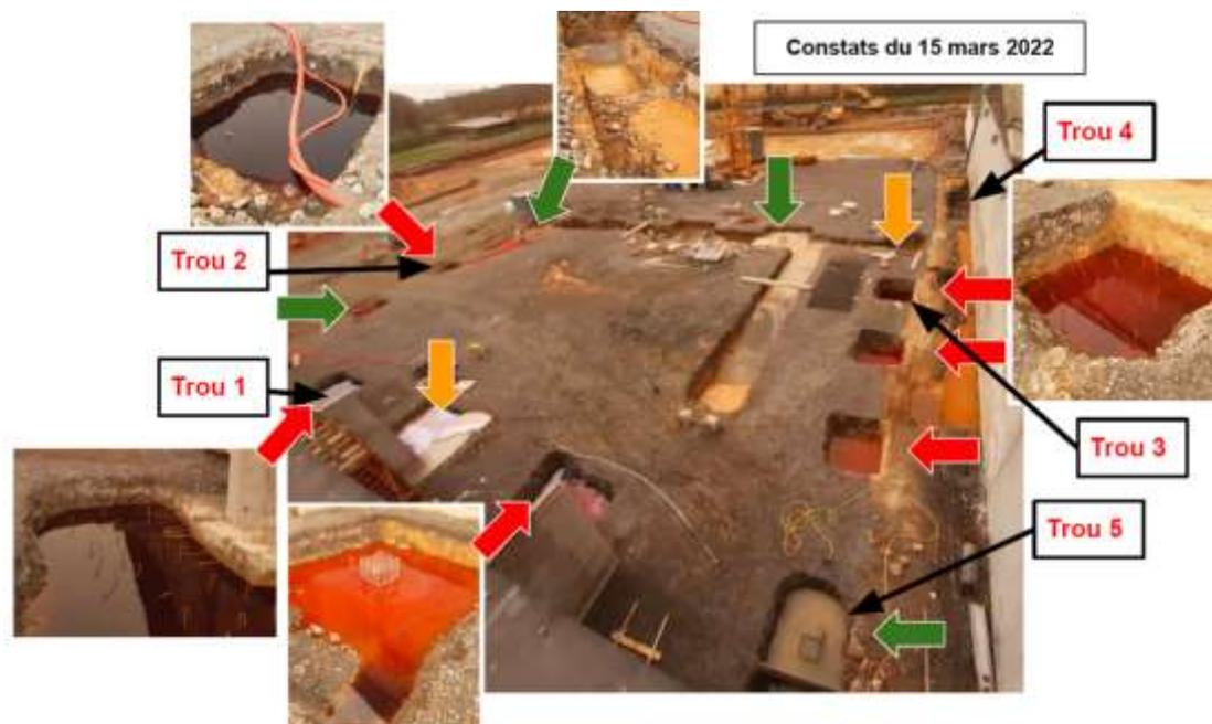
En cas d'écoulement de lixiviats, il est possible de pomper. Cependant, ce type d'écoulement agresse beaucoup les fers à béton. Il n'y a pas de sens à effectuer la dalle pour le moment. Des analyses ont été effectuées. Les taux d'acidité sont incompréhensibles. Des contre analyses sont en cours. Tout a été pompé. À ce jour, il ne semble pas y avoir de résurgence. Un nouvel ordre de service de reprise des travaux sera établi si aucun constat de fuite n'est effectué.
