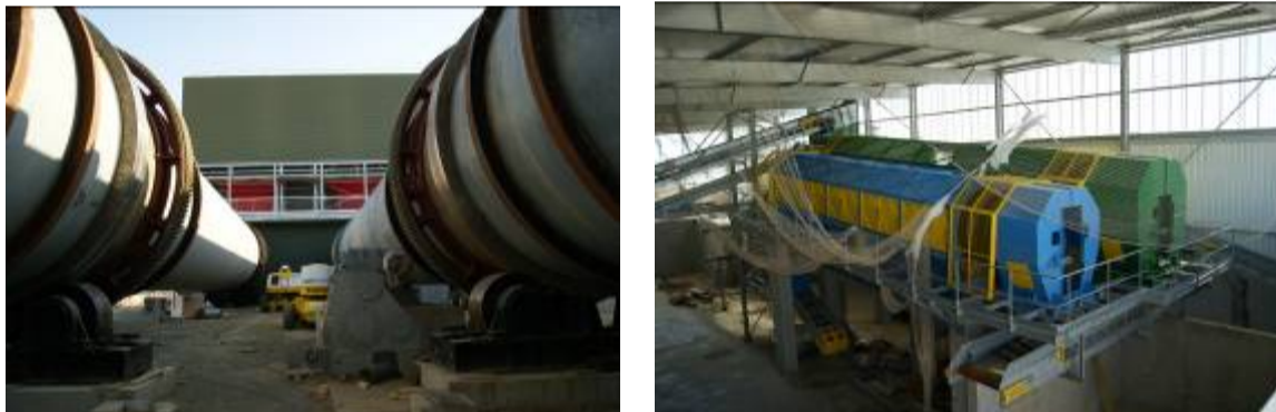
A gauche, les 2 tubes de pré-fermentation, première étape du futur traitement des ordures ménagères récemment installés sur le chantier de l'usine.
